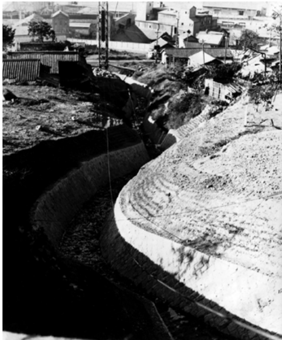
◀ 白木崎川の流路工
