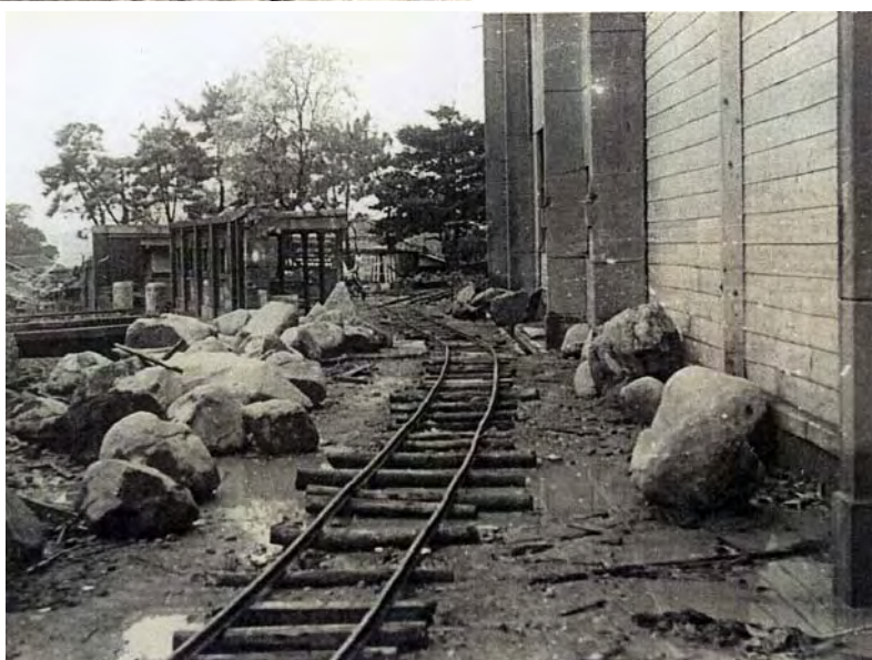
復旧作業中の 小森江西小学校
