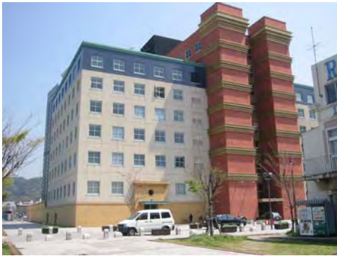
門司港レトロスクエアセンタービル
