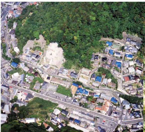
▲ 長谷の急傾斜地崩壊対策事業
