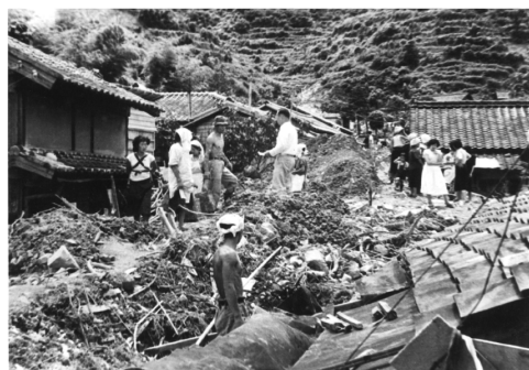
△土砂で埋め尽くされた道路
