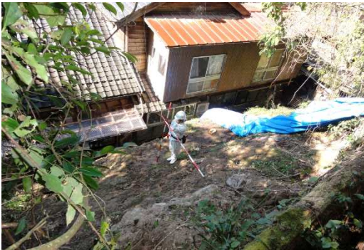
△東峰村宝珠山(栗林(3)-1地区)のがけ崩れ状況
