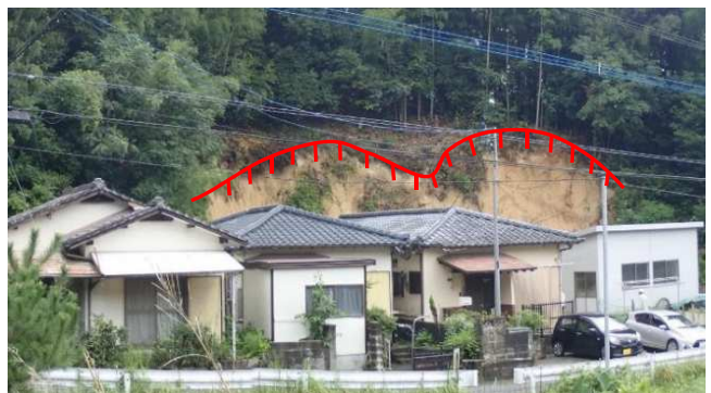
△筑紫野市山家(吉野地区)のがけ崩れ状況
