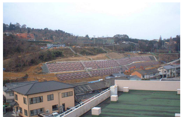
△ 完成した法面工
