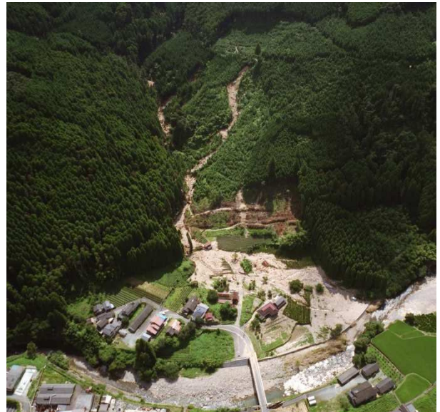
△八女市星野村の土石流発生状況
