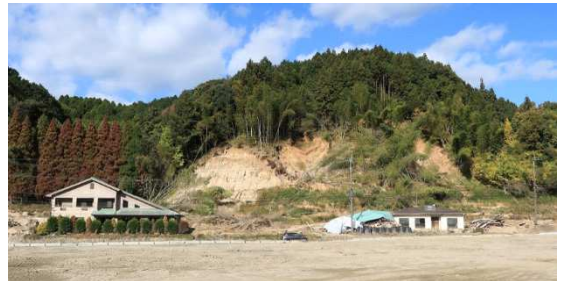
△朝倉市杷木松末(松末地区)のがけ崩れ状況
