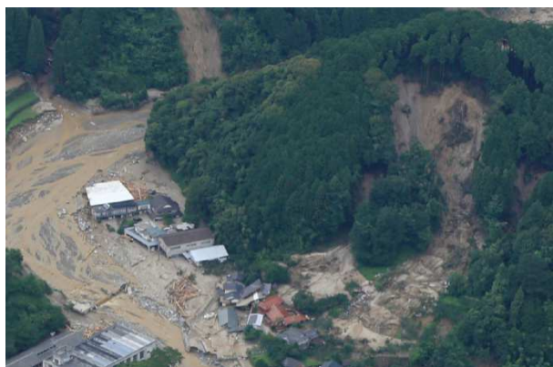
△朝倉市杷木松末のがけ崩れ状況
