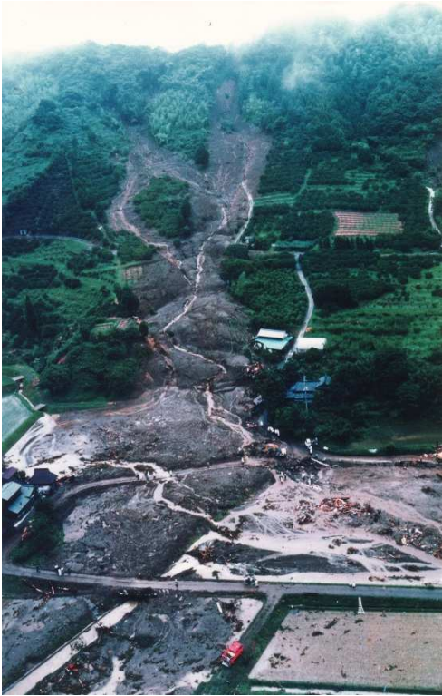
△ みやま市(旧高田町)原地区の被災状況
