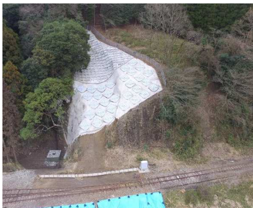
△東峰村宝珠山(大行司駅)のがけ崩れ対策状況
