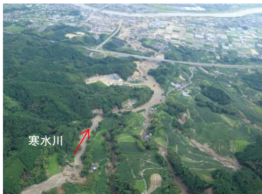
△寒水川の土石流状況(朝倉市)
