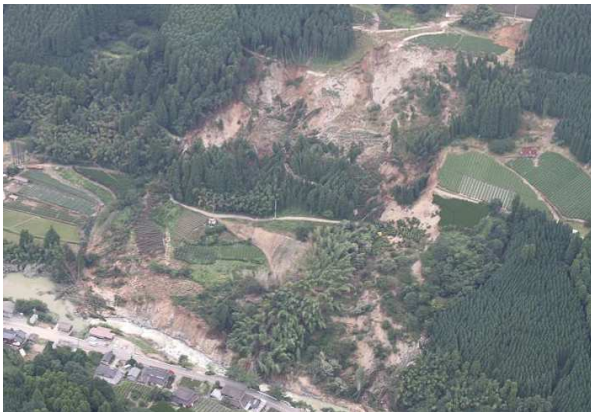
△ 平成24年九州北部豪雨により地すべりが発生
