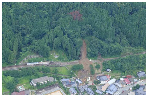
△東峰村宝珠山のがけ崩れ状況
