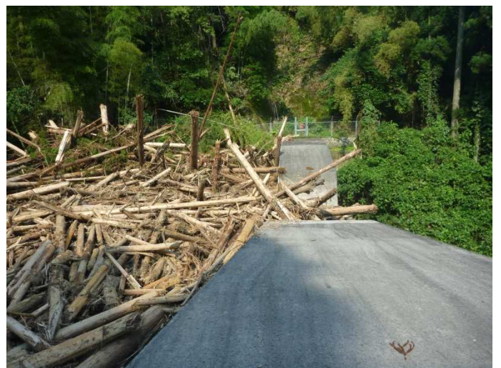
△砂防堰堤による土石流捕捉状況
