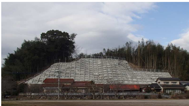
△ 新町地区の法面工(鞍手郡小竹町)
