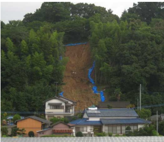
△朝倉市杷木池田のがけ崩れ状況
