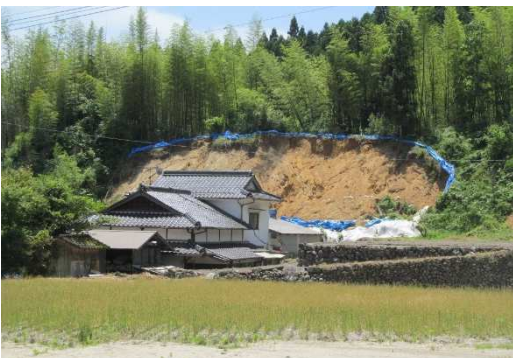
△朝倉市杷木(蔵谷地区)のがけ崩れ対策状況
