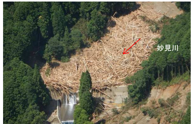
△朝倉市須川(須川第一砂防堰堤)の土石流補足状況
