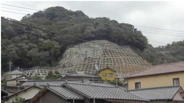
△ 奥田3丁目地区の法面工(北九州市門司区)
