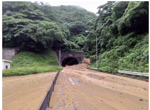
▽ 北九州市門司区の土石流状況
