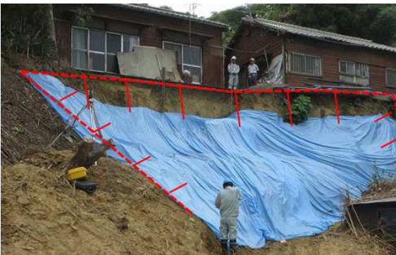
△北九州市八幡西区(瀬板2丁目地区)のがけ崩れ状況
