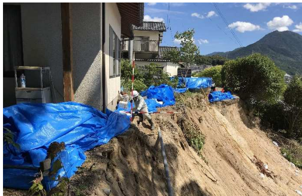
△ 筑紫野市のがけ崩れ状況
