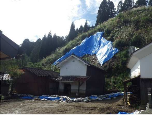
△東峰村宝珠山(屋敷地区)のがけ崩れ状況
