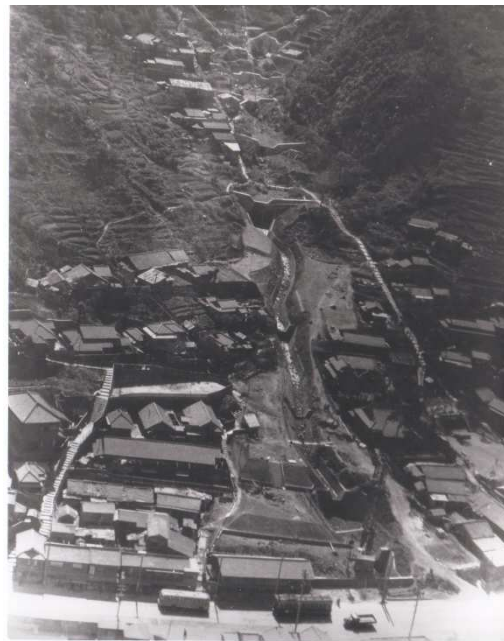
△砂防工事が進む白木崎川（北九州市門司区）
