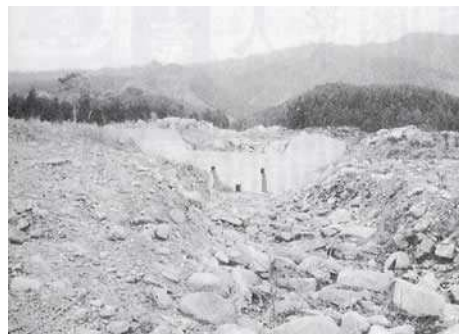
△ 復旧状況(砂防堰堤)
