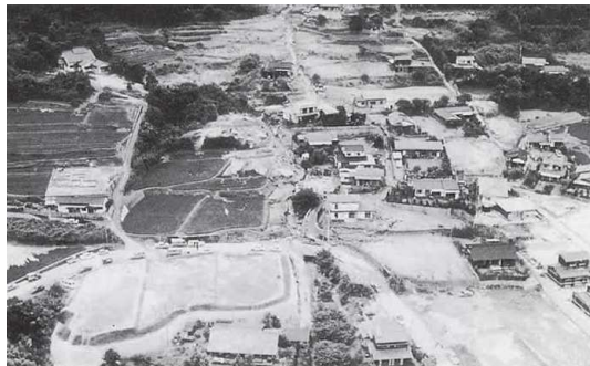
△原川被災状況
