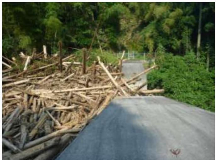
△砂防堰堤による土石流捕捉状況
