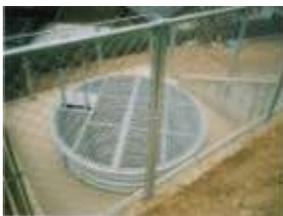
△ 地下水の上昇を抑える集水井工
